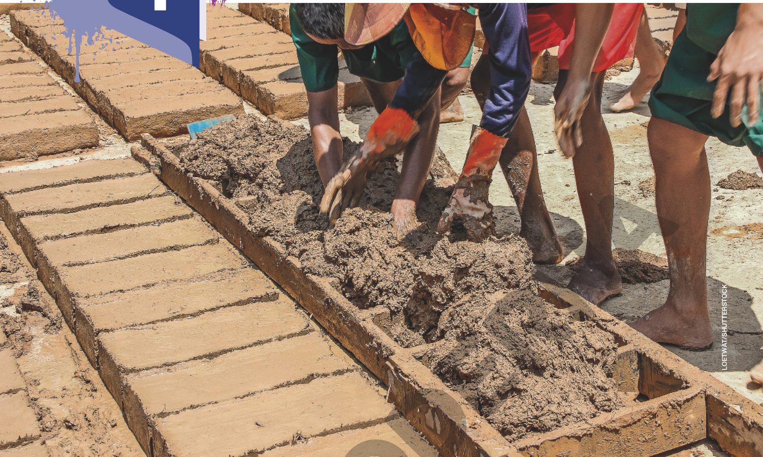
Confeção de tijolos de adobe em vilarejo rural da Tailândia, 2016.
