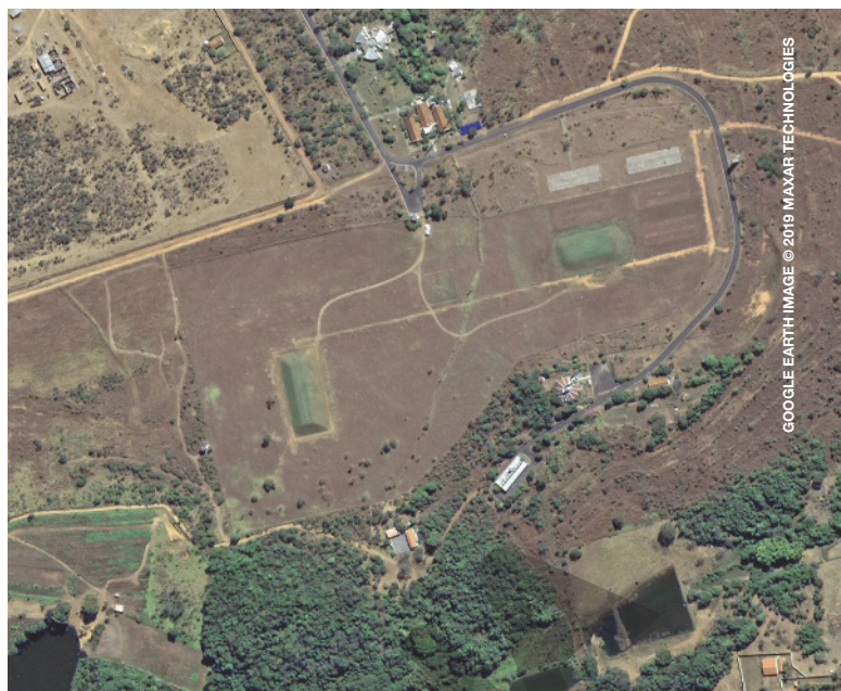
O acidente radiológico de Goiânia gerou 13 toneladas de lixo atômico, que foram enterradas em duas valas de 30 metros de profundidade, revestidas de concreto e cobertas de terra, no Parque Estadual Telma Ortegal, em Goiânia, GO. Imagem de satélite, 2019.
