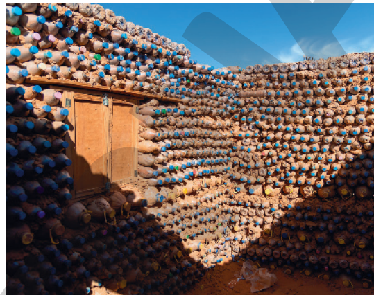
PAREDES FEITAS DE GARRAFA PET EM TINDUFE, NA ARGÉLIA, EM 2018.
