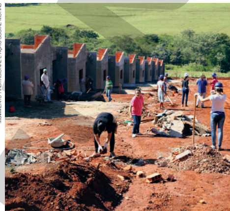
MUTIRÃO CONSTRUINDO MORADIAS NO MUNICÍPIO DE SERRANA, NO ESTADO DE SÃO PAULO, EM 2016.
