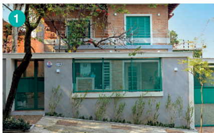
MORADIA NO MUNICÍPIO DE SÃO PAULO, NO ESTADO DE SÃO PAULO, EM 2020.
