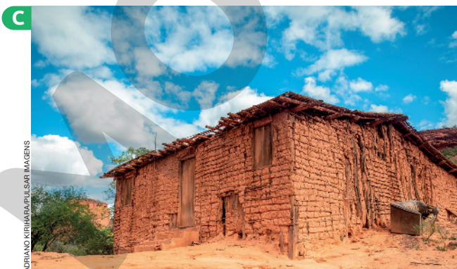
C CASA DE PAU A PIQUE CONSTRUÍDA COM PEDAÇOS DE MADEIRA COBERTOS COM BARRO, EM CANUDOS, NA BAHIA, EM 2019.
