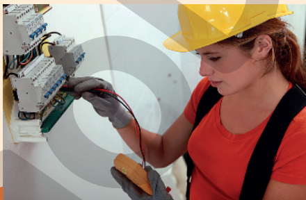
Eletricista realizando um reparo.
