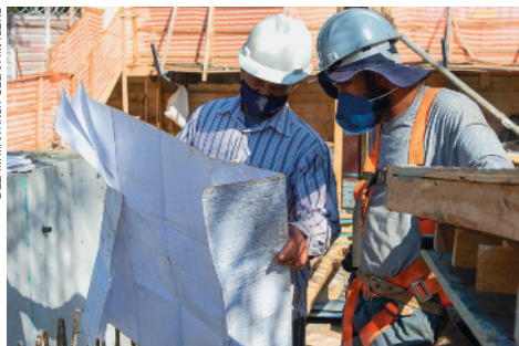
Engenheiro visitando construção no município de São Paulo, no estado de São Paulo, em 2021.
