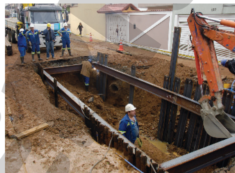
Os técnicos de encanamentos instalam redes de água e fazem seu conserto. Técnicos na cidade de São Paulo, no estado de São Paulo. Fotografia de 2016.
