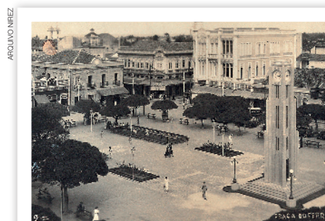
Praça do Ferreira, na cidade de Fortaleza, no estado do Ceará, em 1935.
