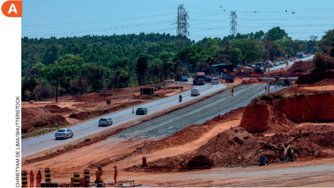
Obras de duplicação de rodovia, na cidade de Cajuru, em Minas Gerais, em 2020.
