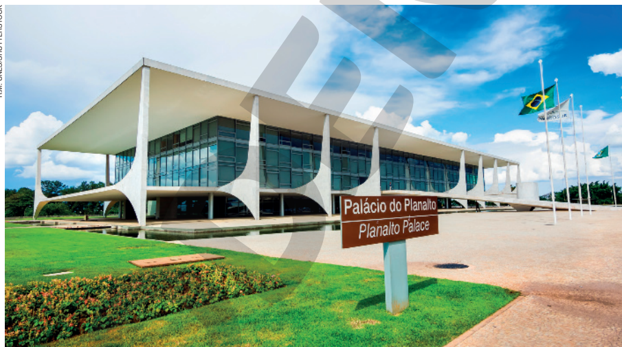
Foto do Palácio do Planalto, sede do Poder Executivo federal, em Brasília, Distrito Federal, em 2015.
