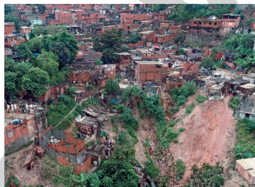
Moradia em área de risco no município de Osasco, no estado de São Paulo, em 2020.
