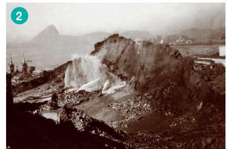
Desmonte do Morro do Castelo na reforma urbana do município do Rio de Janeiro, no estado do Rio de Janeiro, em 1922.
