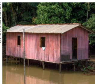
Casa de palafita na Ilha do Combú, município de Belém, estado do Pará, 2018.
