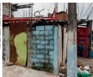
Barracos improvisados, município de São Paulo, estado de São Paulo, 2020.
