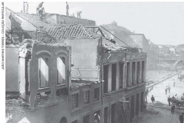
Demolição de sobrados no centro da cidade para dar lugar à Avenida Central, atual Avenida Rio Branco. Município do Rio de Janeiro, estado do Rio de Janeiro, 1904.
