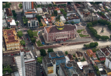
Vista aérea do bairro Centro, no município de Manaus, estado do Amazonas, em 2017. Na imagem, vemos o Teatro Amazonas, a Praça São Sebastião e o Palácio da Justiça.
