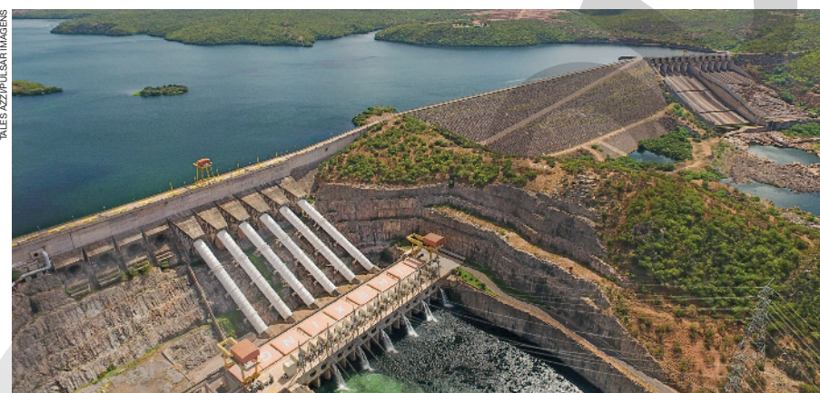
Usina Hidrelétrica de Xingó no Rio São Francisco, no município de Piranhas, no estado de Alagoas, em 2019.
