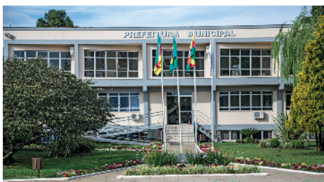
Fachada da Prefeitura Municipal de Esmeralda, no estado do Rio Grande do Sul, em 2018.
