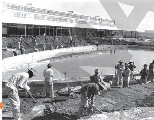
Foto que retrata candangos trabalhando na construção de Brasília, por volta de 1960.
