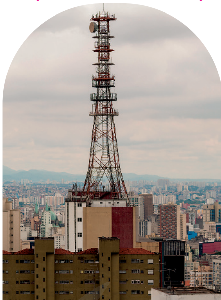
Antena de comunicação localizada no topo de um edifício na cidade de São Paulo, em 2020.
