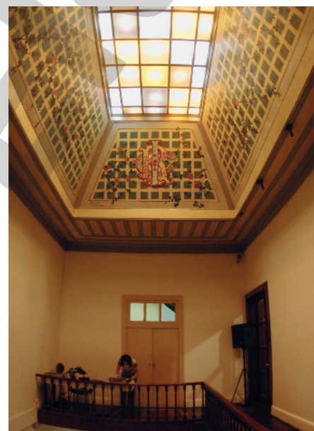
Claraboia iluminada na instalação no Mamam de Recife (PE). Foto de 2006.
