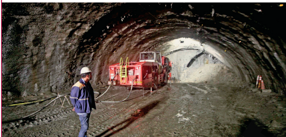
Abertura de túnel no município de Paraibuna, no estado de São Paulo, em 2018.
