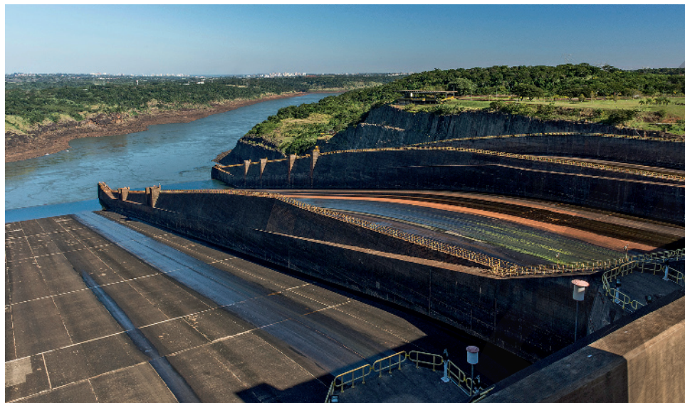
Usina hidrelétrica Itaipu Binacional, no rio Iguaçu, no estado do Paraná, em 2018.
