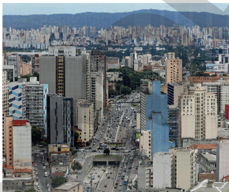
Vista de parte do município de São Paulo, no estado de São Paulo, em 2020.
