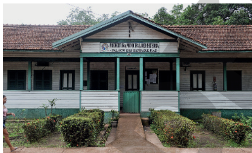
Prédio onde funciona a Prefeitura do município de Belterra, no estado do Pará, em 2017.
