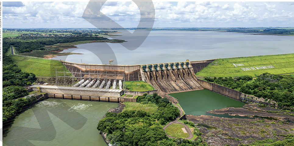
Usina hidrelétrica de Marimbondo, em Icém, no estado de São Paulo, em 2021. Nas usinas hidrelétricas a força das águas é utilizada para gerar energia elétrica.
