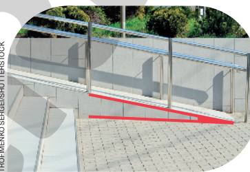
Rampa de acesso.
