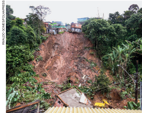
Desabamento de uma moradia devido às fortes chuvas em Ribeirão Pires, São Paulo, 2019.
