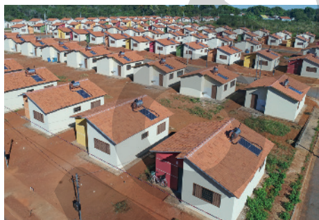
As placas instaladas nos telhados das moradias captam o calor do Sol e o transferem para a água. A água aquecida é utilizada principalmente para o banho. Poconé, MT, 2018.
