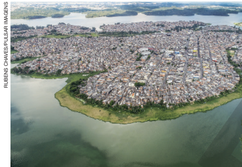
Moradias construídas às margens da Represa Billings, um dos principais reservatórios de água da Região Metropolitana de São Paulo, SP, 2019.
