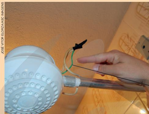
O fio terra tem a função de evitar que a corrente elétrica seja conduzida por nosso corpo e cause um choque elétrico acidental. Assim, qualquer carga elétrica que se acumule no aparelho é conduzida ao solo, pelo aterramento elétrico.
