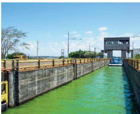
Eclusa no município de Buritama, no estado de São Paulo, em 2019. Em algumas hidrovias brasileiras existem eclusas, pequenos canais construídos em rios onde há desníveis no curso d'água, para possibilitar a subida ou a descida de embarcações.
