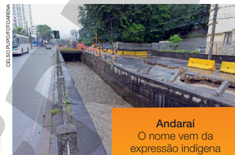
Rio Joana, no município do Rio de Janeiro, no estado do Rio de Janeiro, em 2019.
