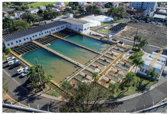
Estação de tratamento de água no município de Presidente Prudente, no estado de São Paulo. Fotografia de 2020.
