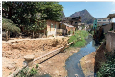
Despejo de esgoto em córrego na cidade de Pancas, no estado do Espírito Santo. Fotografia de 2019.
