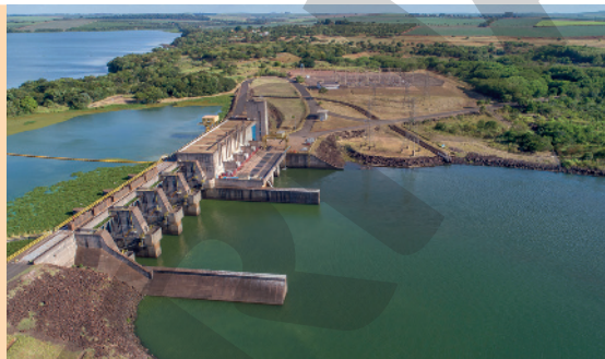
Vista da usina hidrelétrica de Canoas II, no município de Palmital, em São Paulo, em 2020.
