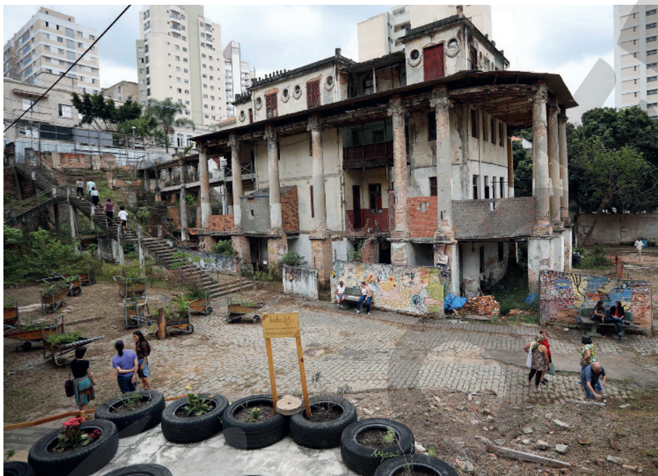
Construção deteriorada no centro da cidade de São Paulo, em 2019.
