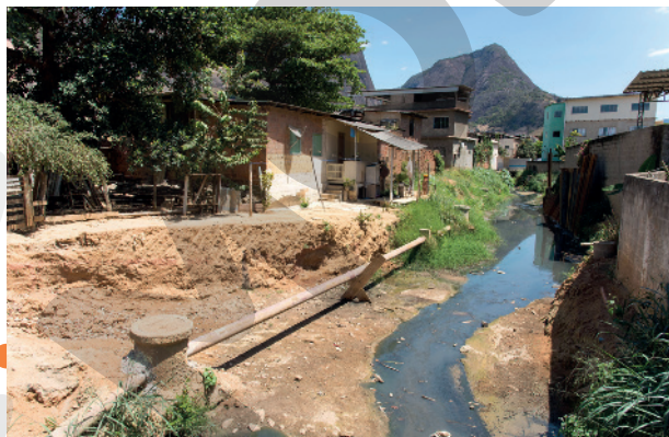
Vista de moradias construídas em margem de córrego na cidade de Pancas, no Espírito Santo, em 2019.
