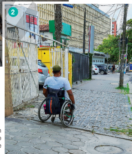
Calçada irregular e com obstáculo na cidade de Recife, no estado de Pernambuco, em 2021.
