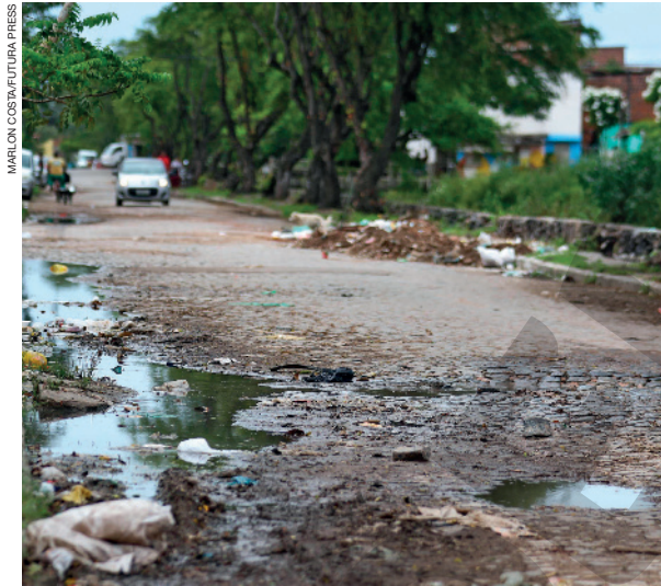
Esgoto a céu aberto no município de Recife, no estado de Pernambuco, em 2020.
