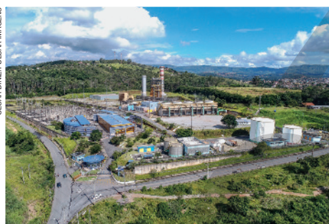
Usina termelétrica a gás natural no município de Ibité, no estado de Minas Gerais, em 2019.
