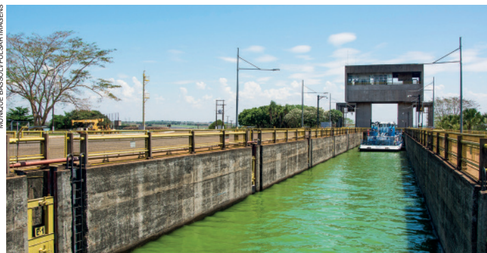
Barco saindo de eclusa no município de Buritama, no estado de São Paulo, em 2019. Algumas hidrovias existentes no Brasil apresentam eclusas para as embarcações transporem locais onde existe desnível no curso-d'água.
