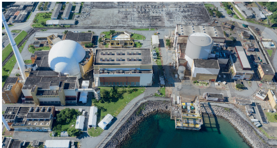
Usina nuclear no município de Angra dos Reis, no estado do Rio de Janeiro, em 2019.
