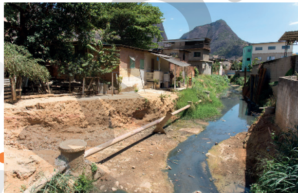
Vista de moradias construídas em margem de córrego na cidade de Pancas, no Espírito Santo, em 2019.
