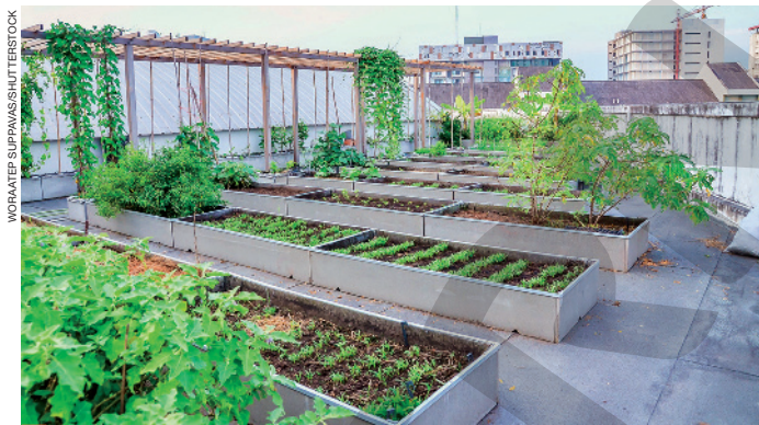
Exemplo de agricultura urbana em um telhado verde.
