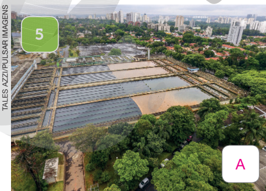
Estação de tratamento de água do Alto da Boa Vista, Sistema Guarapiranga, na cidade de São Paulo, no estado de São Paulo. Fotografia de 2017.
