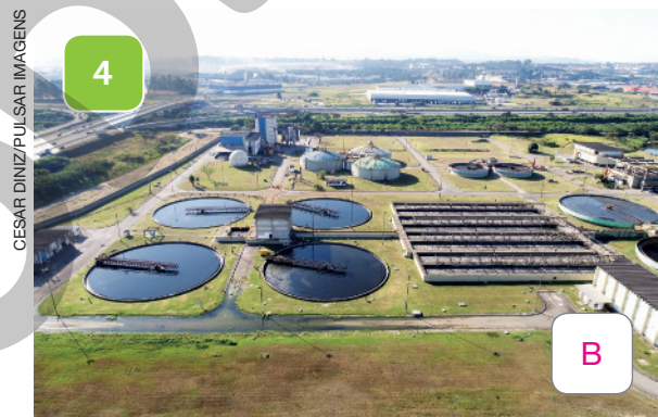
Estação de tratamento de esgoto São Miguel, na cidade de São Paulo, no estado de São Paulo. Fotografia de 2021.
