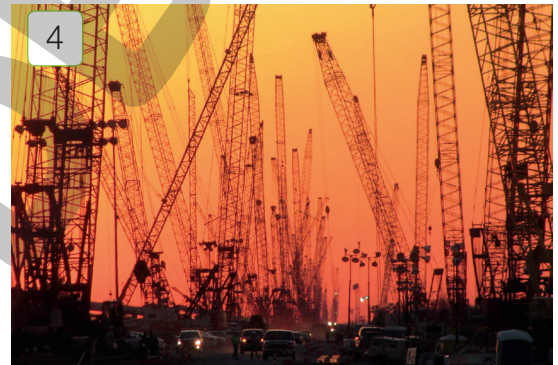
Construções na cidade de Nova Orleans, nos Estados Unidos. Fotografia de 2011.
