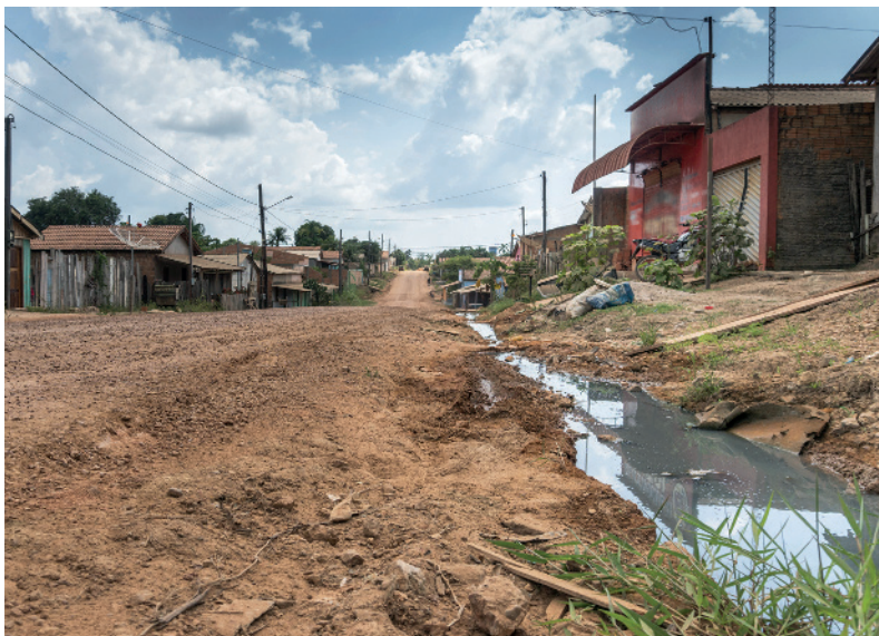
Esgoto doméstico a céu aberto em rua no município de Anapu, estado do Pará, em 2019.
