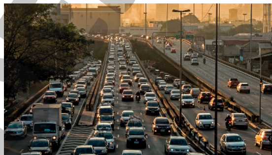
Avenida Radial Leste, São Paulo (SP), em junho de 2018.
