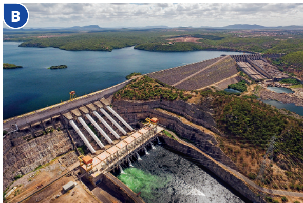
Usina hidrelétrica de Xingó no município de Piranhas, no estado de Alagoas, em 2019.
