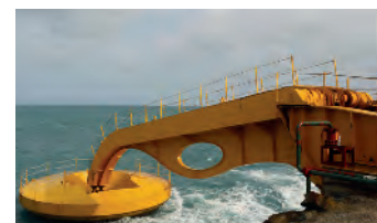
Usina-piloto de ondas geradoras de energia elétrica. (São Gonçalo do Amarante, CE, 2012.)
