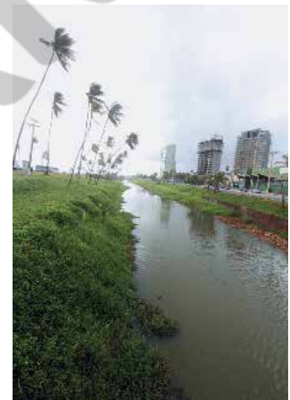
Vista de parte do rio Jaguaribe que irá receber calhas de concreto em suas margens, Salvador, BA (2017).
