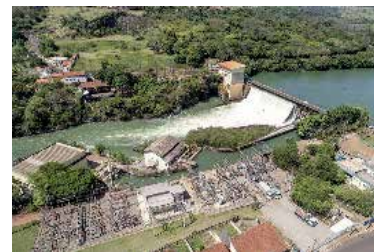
Vista aérea da Usina Hidrelétrica de Piraju, SP (2019).
