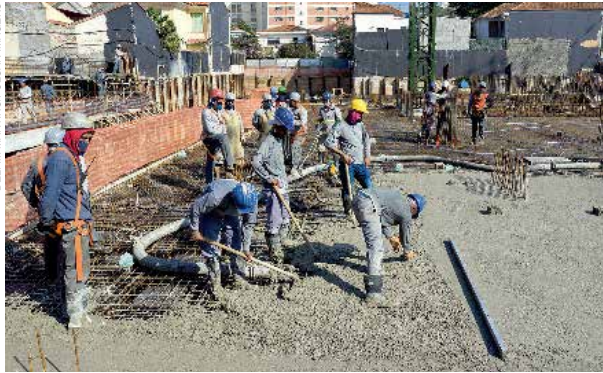
Operários trabalham em construção de edifício, São Paulo, SP (2021).
