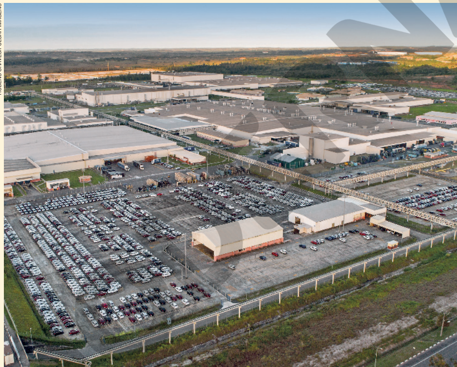
Vista aérea do Polo Industrial de Camaçari, BA (2017).
