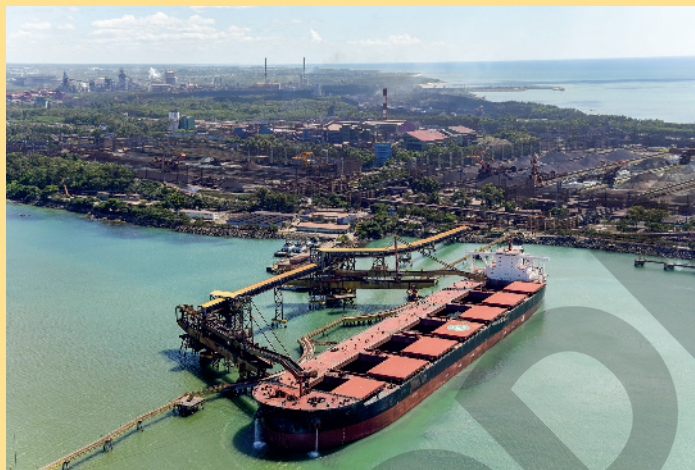
Porto de Tubarão, em Vitória (ES), o maior terminal de exportação do minério de ferro produzido em Minas Gerais. Fotografia de 2016.
