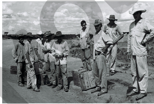
Grupo de homens chega para trabalhar na construção de Brasília, DF (1959).
