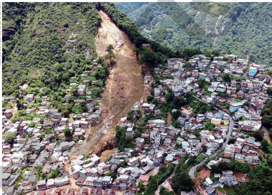
Vista aérea de deslizamento de terra ocorrido em Petrópolis, RJ (2022).
