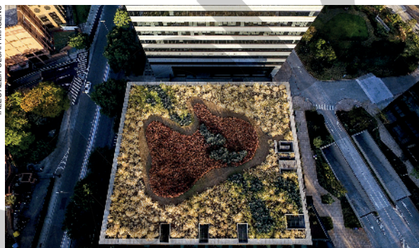
Telhado verde em São Paulo, SP (2020). O telhado verde faz parte de um projeto arquitetônico moderno que, além de ampliar espaços com áreas verdes, reduz a temperatura dos ambientes internos.
