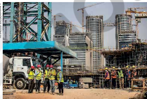
Trabalhadores egípcios e chineses em obra realizada no Cairo, Egito (2021).
