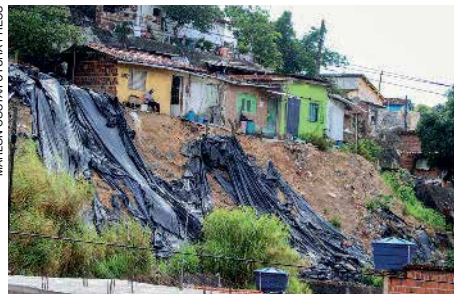
Desabamento de casas em decorrência de deslizamentos relacionados às fortes chuvas em locais íngremes, em Recife, PE (2018).
