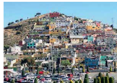
Vista da comunidade Las Palmitas antes das intervenções. Pachuca, México (2014).
