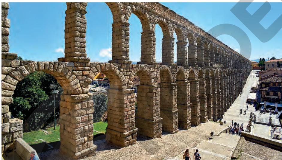
Ruínas de aqueduto dos séculos II a.C.-I a.C., em Segóvia, na Espanha. Na Antiguidade, essas construções formavam o sistema de canalização de água para o abastecimento das cidades. Fotografia de 2021.
