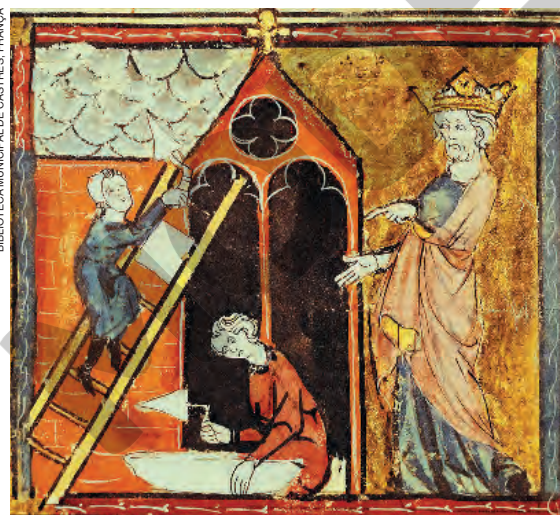
Construção de uma igreja no reinado de Luís VI. Século XIV. Iluminura. Biblioteca Municipal de Castres, França.
