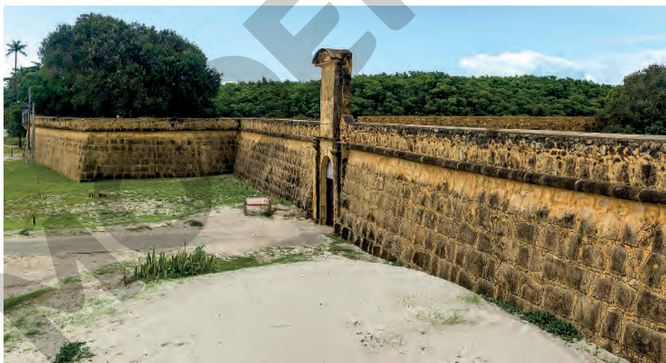
O Forte Orange, construído em 1631 pelos holandeses na Ilha de Itamaracá, em Pernambuco, logo após a conquista, era originalmente feito de taipa. Após a expulsão dos holandeses, em 1654, o forte, que estava em ruínas, foi reformado e revestido de pedra pelos portugueses. Fotografia de 2021.
