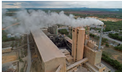
Chaminé em indústria de cimento. (Mossoró, RN, 2019.)
