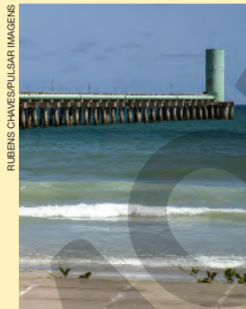
Um emissário submarino é uma longa tubulação que leva os despejos líquidos de uma cidade litorânea para o mar, longe das praias. (O emissário submarino desta foto fica na praia urbana de Sobral, em Maceió, AL, 2015.)
