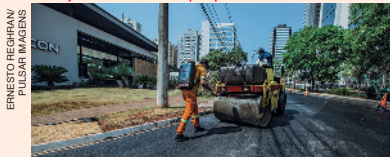
Recapeamento do asfalto da avenida Ayrton Senna, em Londrina (PR). Foto de 2020.
