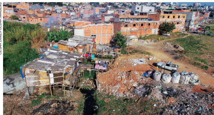
Moradias precárias e córrego poluído por esgoto na cidade de São Paulo, SP (2021).
