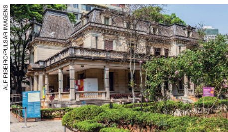
Fachada do Espaço Haroldo de Campos de Poesia e Literatura, na cidade de São Paulo, no estado de São Paulo, em 2021.
