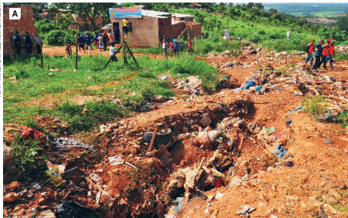
A Agência de Fiscalização do Distrito Federal faz operação para remoção de moradias e famílias em situação de risco por causa de uma erosão no solo, em Ceilândia, região administrativa do Distrito Federal (2016).
