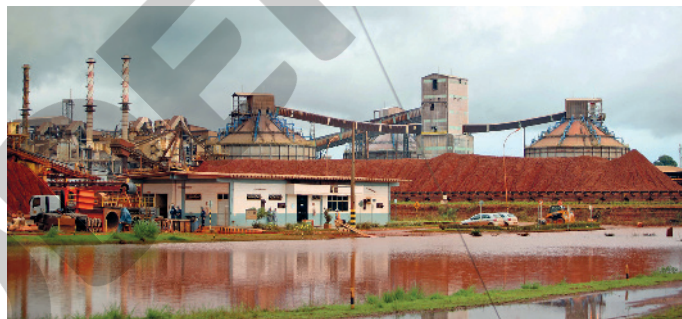
Indústria de processamento da bauxita para a produção de alumínio no município de Barcarena, PA (2018).
