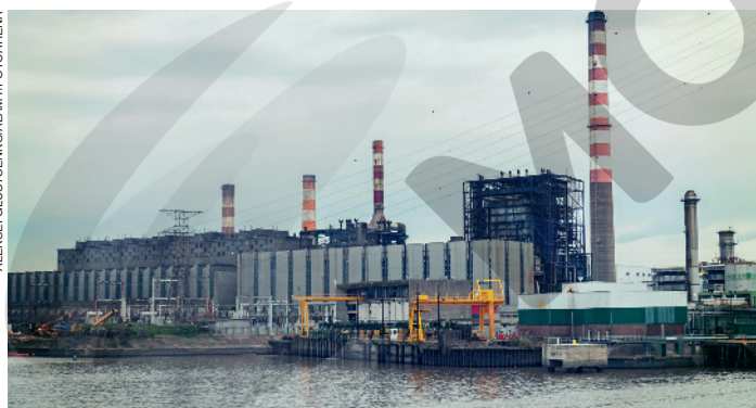
Na foto, vista da Central Térmica Costanera, usina termelétrica à gás natural em Buenos Aires, Argentina (2019).
