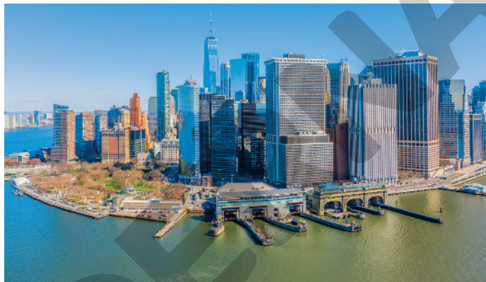
Vista de edifícios no distrito financeiro da cidade de Nova York, Estados Unidos (2020), que possuía 8,3 milhões de habitantes, em 2019, e sua região metropolitana, 18,8 milhões.
