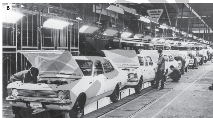
Dois momentos da indústria automobilística no Brasil. Na foto A, linha de montagem da estadunidense Ford, no Rio de Janeiro, RJ (1925); na foto B, linha de montagem da General Motors, também originária dos Estados Unidos, em São Caetano do Sul, SP (década de 1960).
