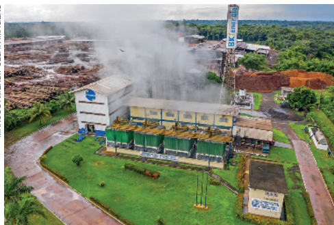
Instalações de usina termelétrica que usa resíduos de madeira para produzir eletricidade, no município de Itacoatiara, AM (2019).
