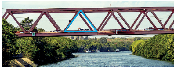
Estrutura metálica da ponte Victório Maniero, sobre o rio Tietê, no município de Igarapé do Tietê, São Paulo. (Fotografia de 2019.)
