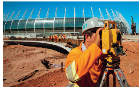
Medição de ângulos feita com teodolito em uma obra, Fortaleza (CE). (Fotografia de 2013.)
