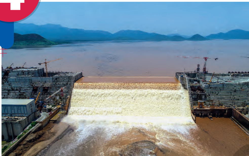
Barragem da hidrelétrica Grande Renascença Etíope em Guba, no noroeste da Etiópia. Foto de 2020.
