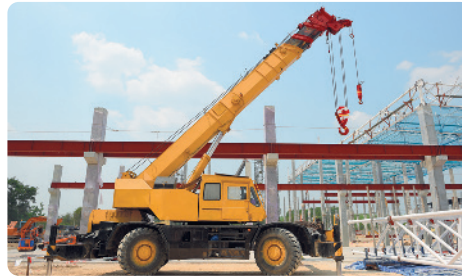
Guindaste usado na construção civil.
