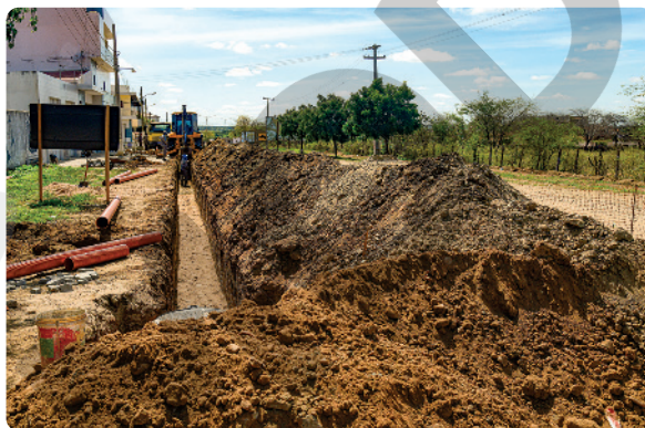
Obra de instalação de rede de esgoto no município de Taperoá, PB, em 2022.
