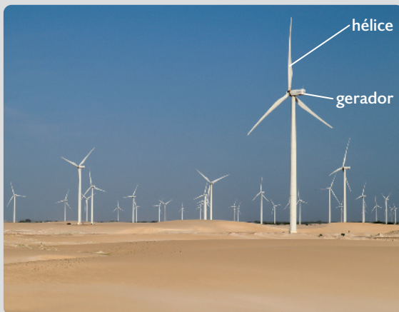
Aerogeradores de usina eólica localizada no município de Galinhos, RN, em 2020.
