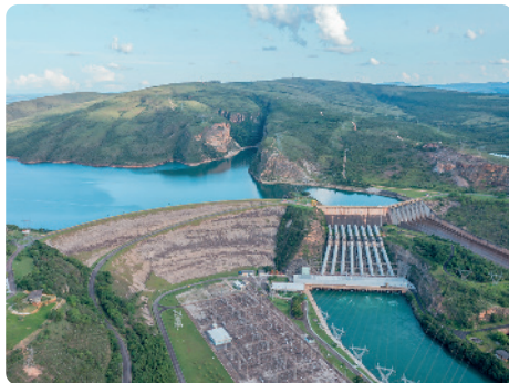
Usina hidrelétrica de Furnas, no município de São José da Barra, MG, em 2022.
