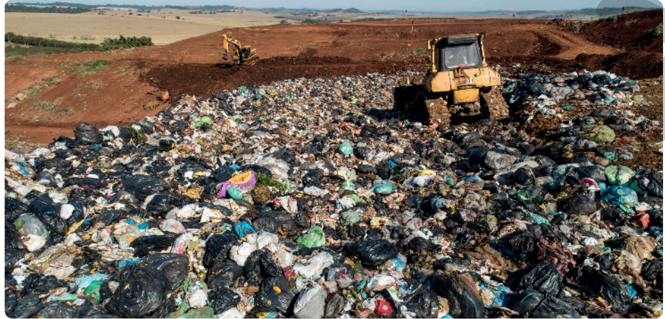
Trator fazendo a compactação dos resíduos sólidos no aterro sanitário, no município de Londrina, PR, em 2019.
