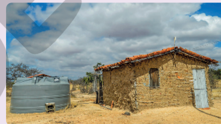
Casa de taipa com cisterna de captação de água na Aldeia Pankará, no município de Itacuruba, PE, em 2019.
