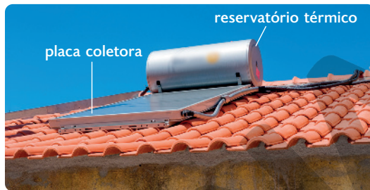
Aquecedor solar no telhado de uma residência, em Castelo Branco, Portugal, em 2022.
