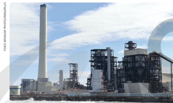
Usina termonuclear de Fukushima, Japão, em 2021, dez anos após o tsunami que danificou parte de sua estrutura.
