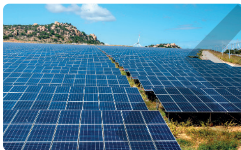
Usina solar no Vietnã, em 2020.
