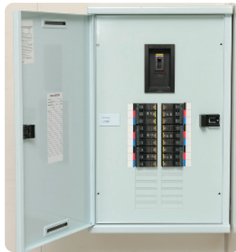
Caixa de disjuntores de uma residência.
