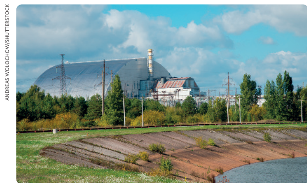
Usina termonuclear de Chernobyl na Ucrânia, em 2021. Nessa imagem é possível identificar uma estrutura metálica cobrindo o reator 4, danificado no acidente de 1986.
